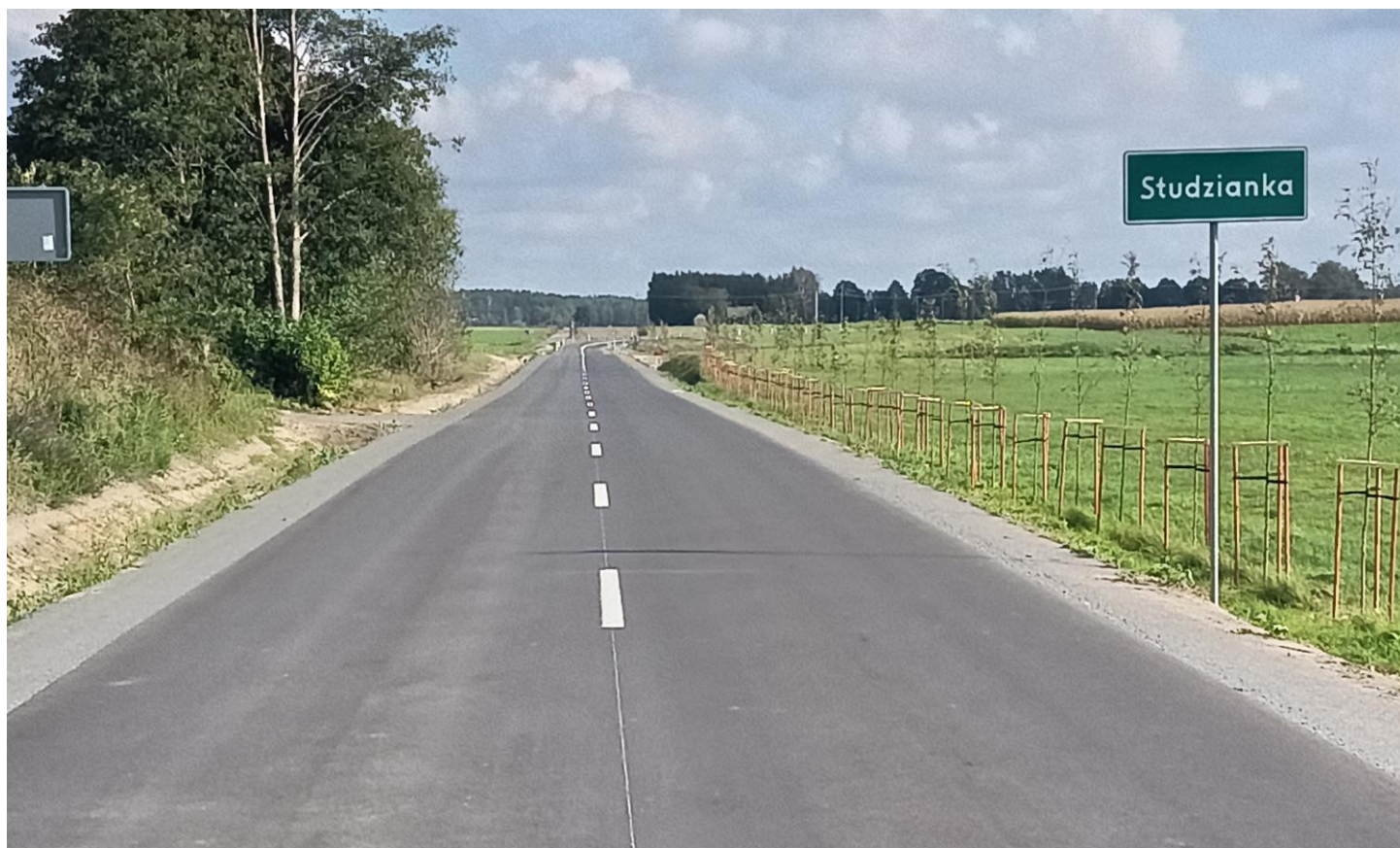
Prace na drodze do Lubenki zbliżają się ku końcowi.
