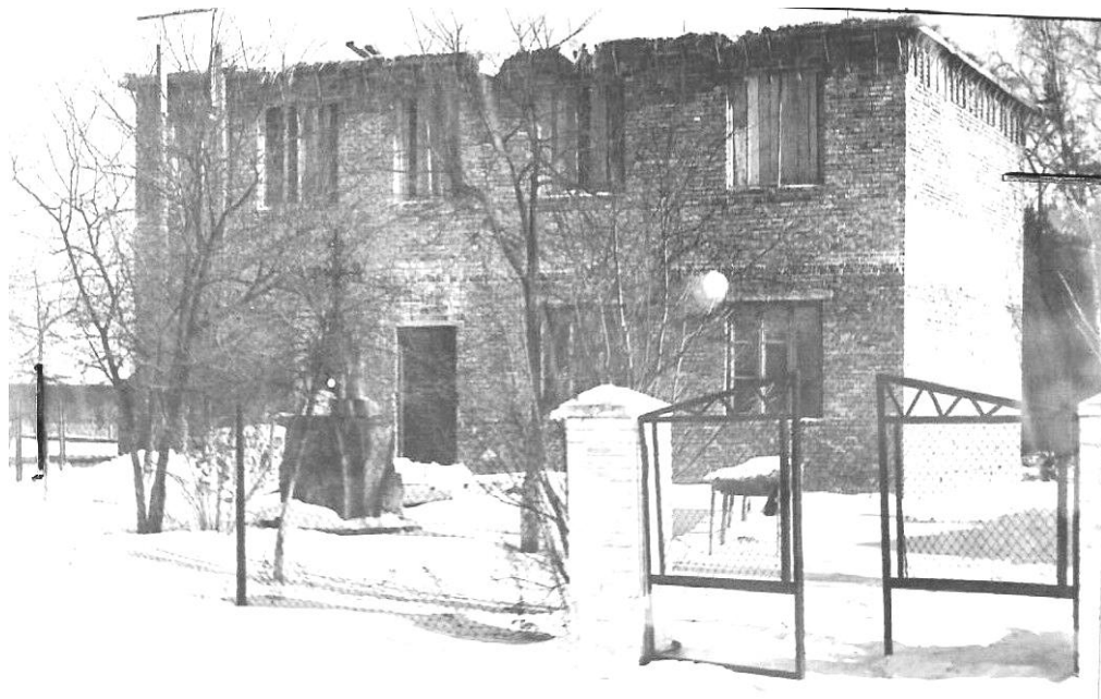
Budynek szkoły przed przebudową.
